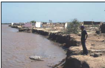
Zerstörte Freiheit: Hochwasserschäden in Nordperu
