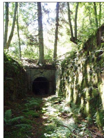
Alter, von Farnen überwachsener Stolleneingang
