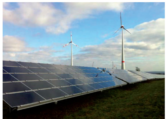
Solar- und Windpark, Wörrstadt
