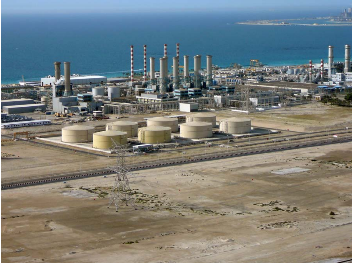
Meerwasserentsalzungsanlage in Dubai
